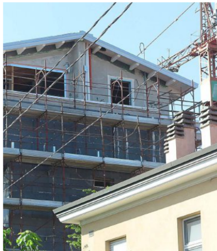
Un cantiere edilizio
